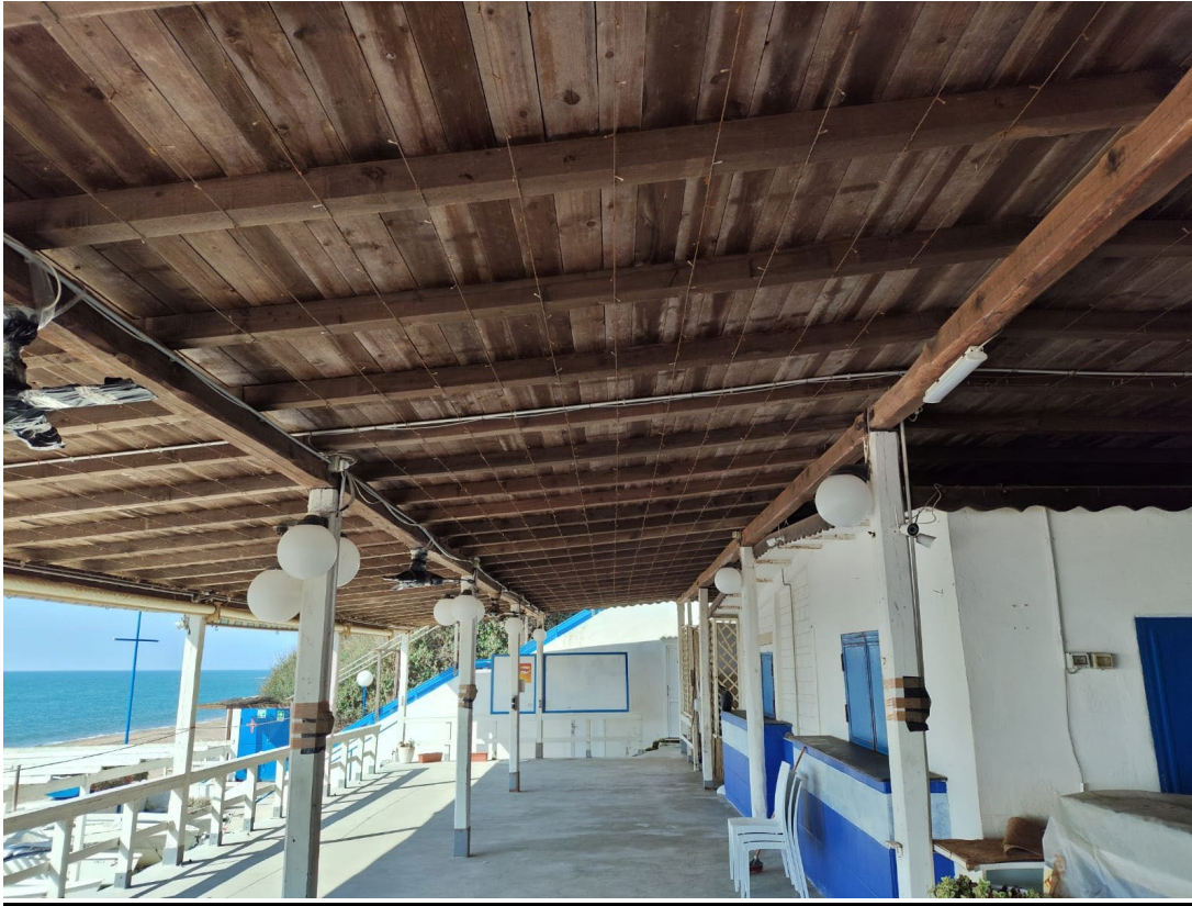
Tettoia in legno a copertura dell'area ristorante/bar
